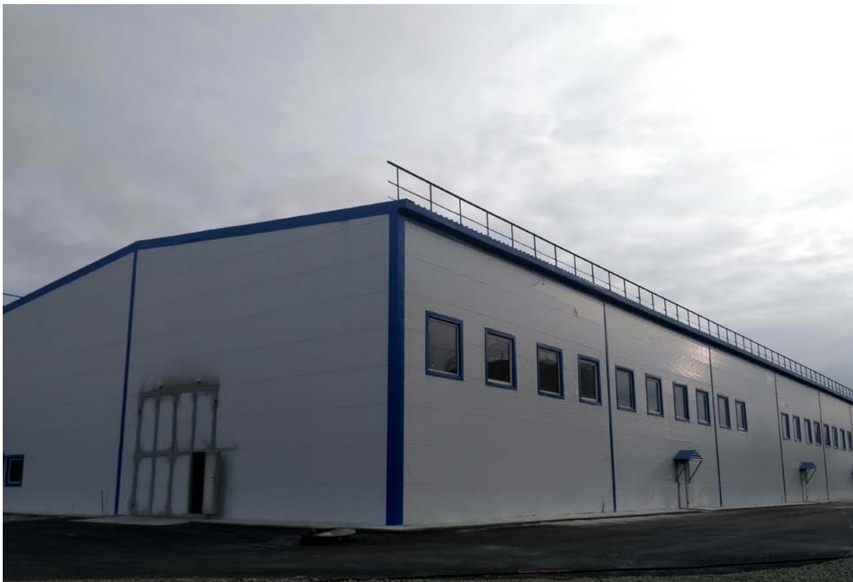
Рис. 16. Внешний вид хозяйственно-питьевого водозабора №1
