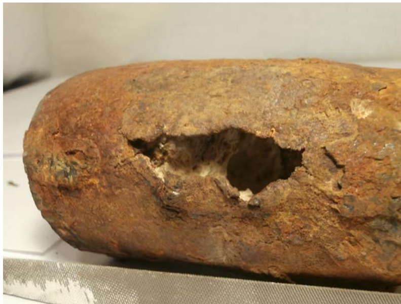
Рис. 8. Разрыв стенки трубы вследствие отложения накипи.
